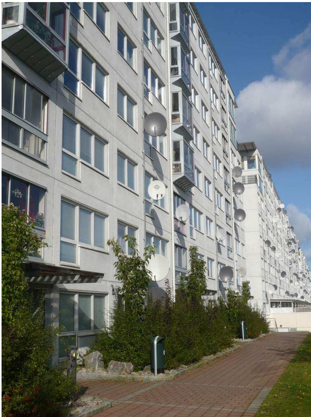
Fornytt utemiljø og oppussede fasader med helhetlig løsning for individuelle parabolantennener
