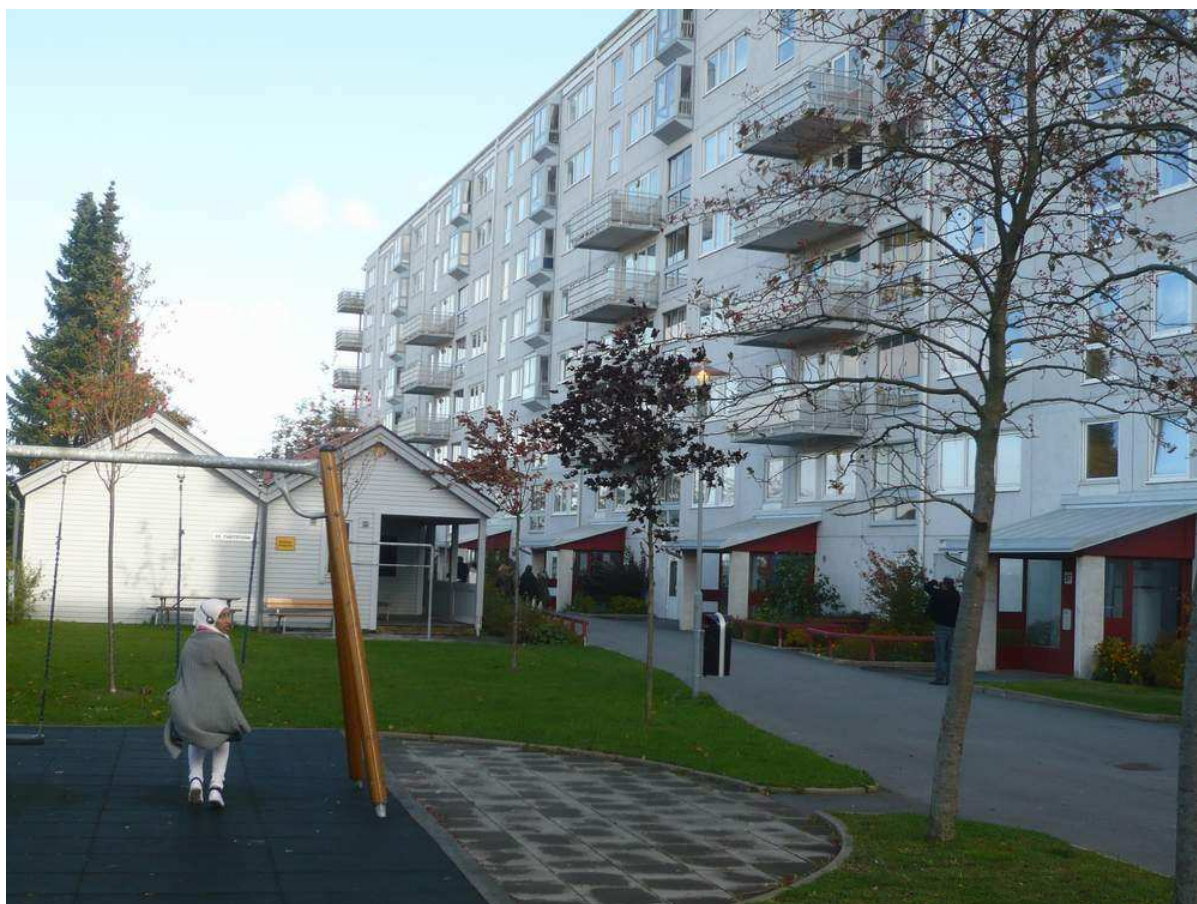
Blokker med fornyede fasader, karnapper og balkonger
