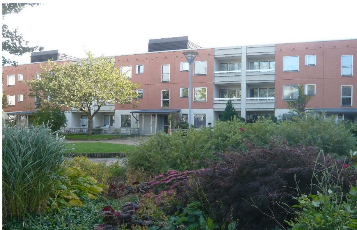
Fornyset utemiljø og enkel fasaderehabilitering gav stor effekt
